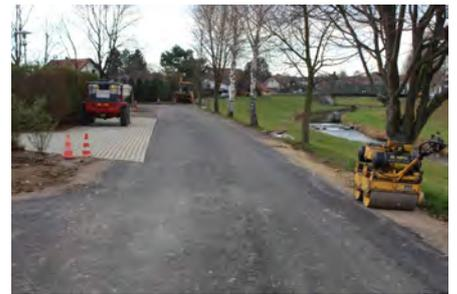
Im Zuge der Bauarbeiten hat sich herausgestellt, dass der alte Asphalt nur auf einer dünnen Gräderschicht aufgebracht war.
