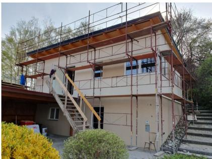
Der aktuelle Bestand, ein geschalteter Betonbau wird komplett renoviert und bekommt eine Herenumkleide mit 2 Duschen. Ebenso entsteht durch eine eingezogene Wand ein Lager für Trainingsgeräte. Bei dem neu aufgebauten Obergeschoss wurden ein großer Aufenthaltsraum mit Küche, eine Damenumkleide und zwei Toiletten geplant. Ebenso wird auf der bestehenden Pergola eine kleine Terrasse mit Sitzgelegenheiten entstehen.
