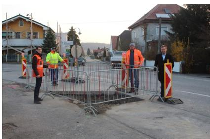
Im Zuge dieser Grabungsarbeiten wurden Hausanschlüsse für die Wasserleitung, den Regenwasser- und Schmutzwasserkanal hergestellt.
